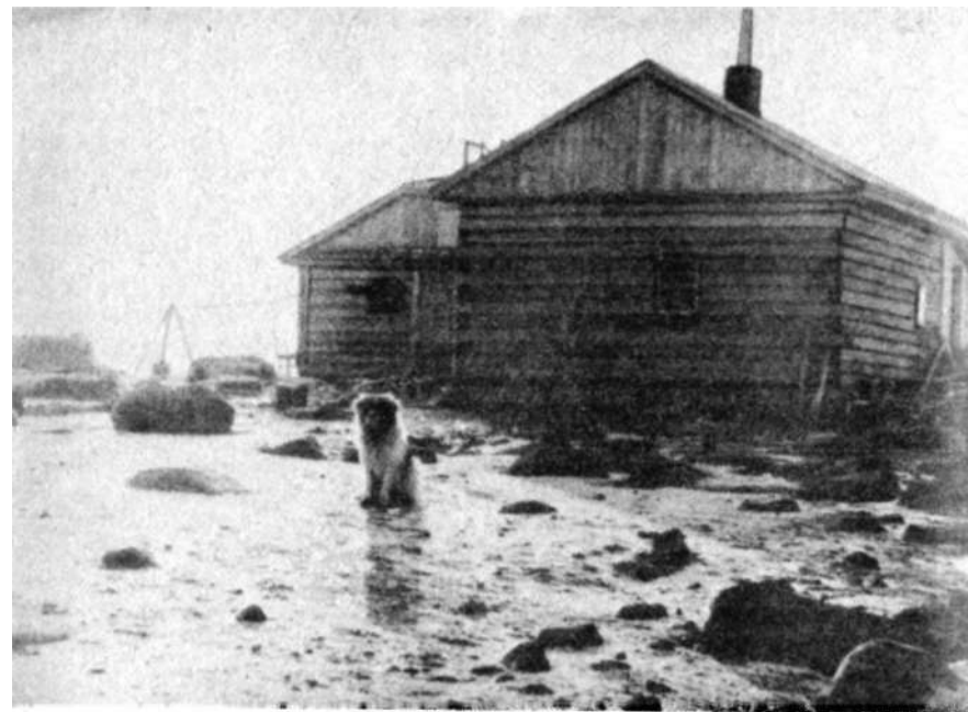
Жилой дом на островной полярной станции
